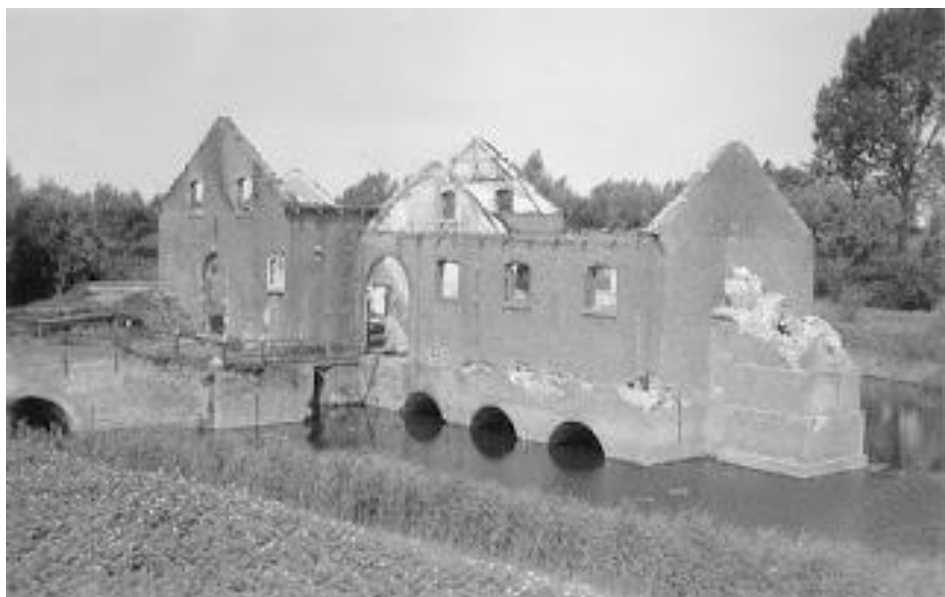
Afb. 19a De restanten van het Herwijnsen stoomgemaal dat aan het begin van de Tweede Wereldoorlog afgebroken werd in verband met het schootsveld van het fort
