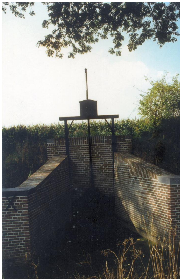
Afb.13 Duikersluisje Poldersekade na de restauratie
